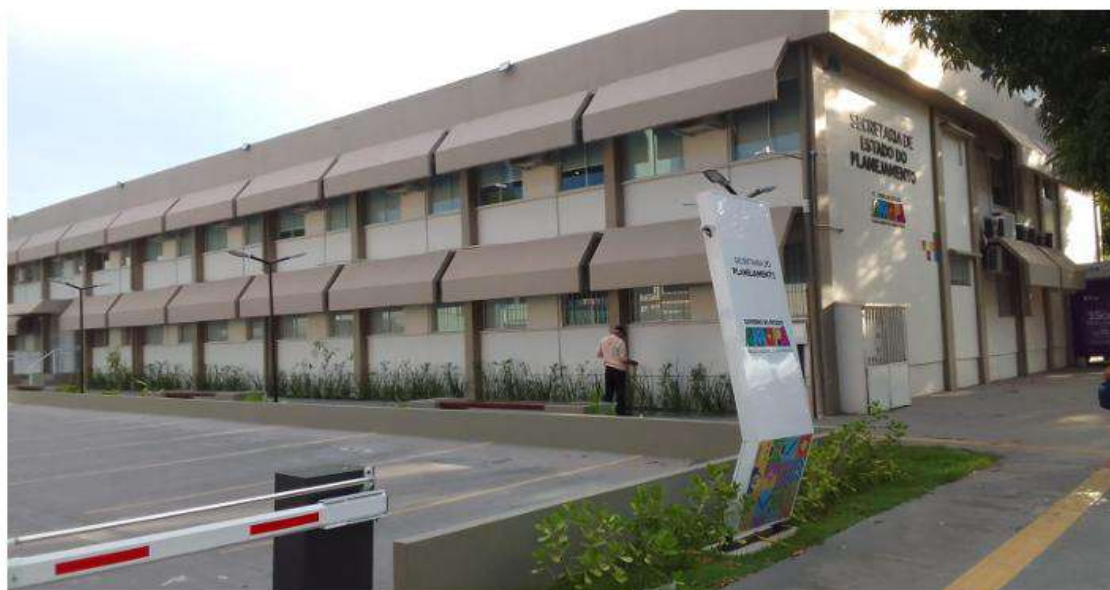
SEPLAN ENTRADA DE ESTACIONAMENTO E PLACA DE IDENTIFICAÇÃO
